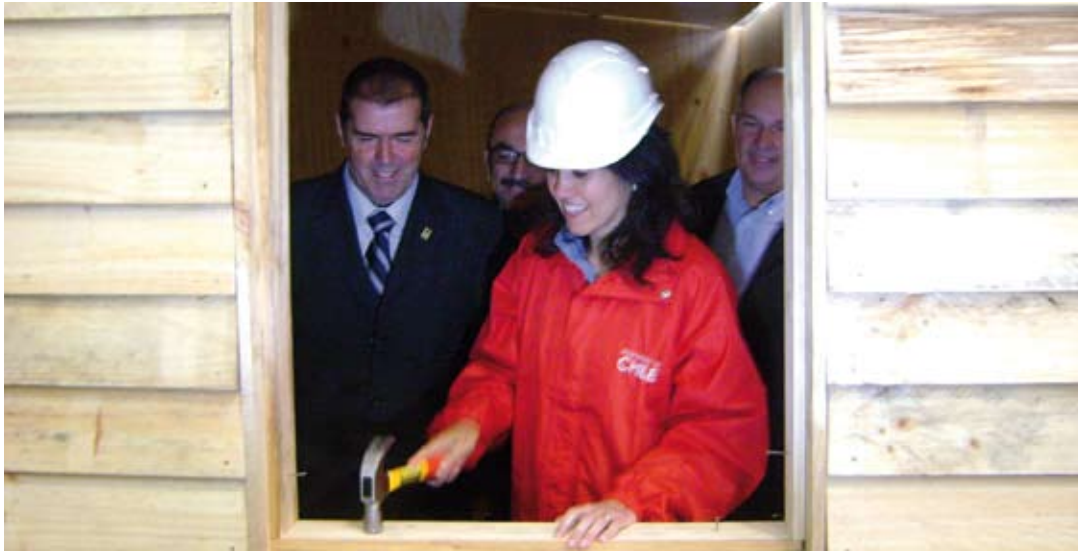
La ministra del Trabajo, Camila Merino, y el Presidente de CORMA Biobío, Jorge Serón, supervisaron la construcción de mediaguas.
