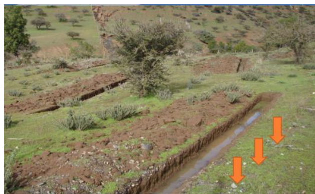
Figura 8. Zanja de infiltración, la que por medio del análisis hidrológico de la zona, permite generar infiltración en zonas con o sin vegetación. Fuente: Elaboración propia.
